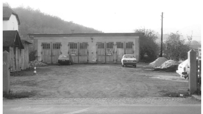
Das ehemalige Rüsthaus der FF. Straßgang im Jahr 1980, damals ein Schotterlager für den Bedarf von mehreren „Stroßenkrampeln“ (Weginstandhalter der Gemeinde). In einer Eigeninitiative und mit vielen Anstrengungen entstand daraus das heutige Kulturzentrum.
