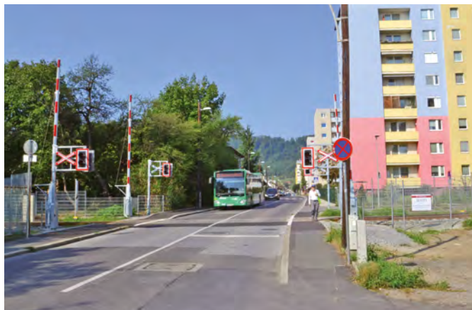
Im Juli 2019 wurde die Schrankenanlage in der Grottenhofstraße in Betrieb genommen. Diese sorgt für mehr Sicherheit beim Überqueren der Gleise.
